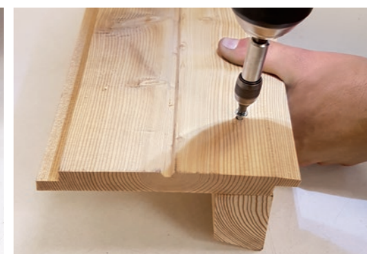
3. Fixer les profilés à claire-voie sur les lames à mi-bois, par l'arrière et à l'aide des vis.
